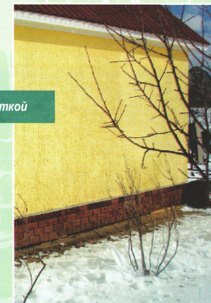
Облицовка цоколя блоками «зигзаг», расположенными горизонтально, без раствора в швах. Арх. М. Гродников
